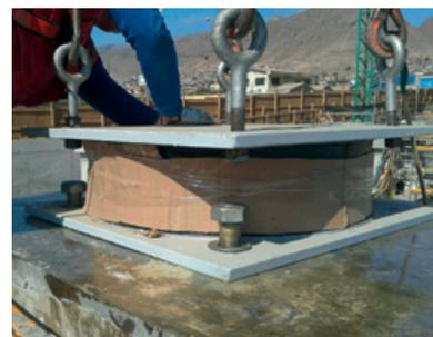
compuesto elastomérico usado en los aisladores, mejorando así el desempeño del edificio. Con el sistema de aislamiento propuesto se logran reducir en más de un 80% las aceleraciones en la “estructura”, comenta Gabriel Sanhueza, jefe de Proyectos del Área de Mediciones y Ensayos de SIRVE S.A.
