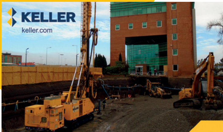
Columnas de Grava en Edificación (CHILE)
