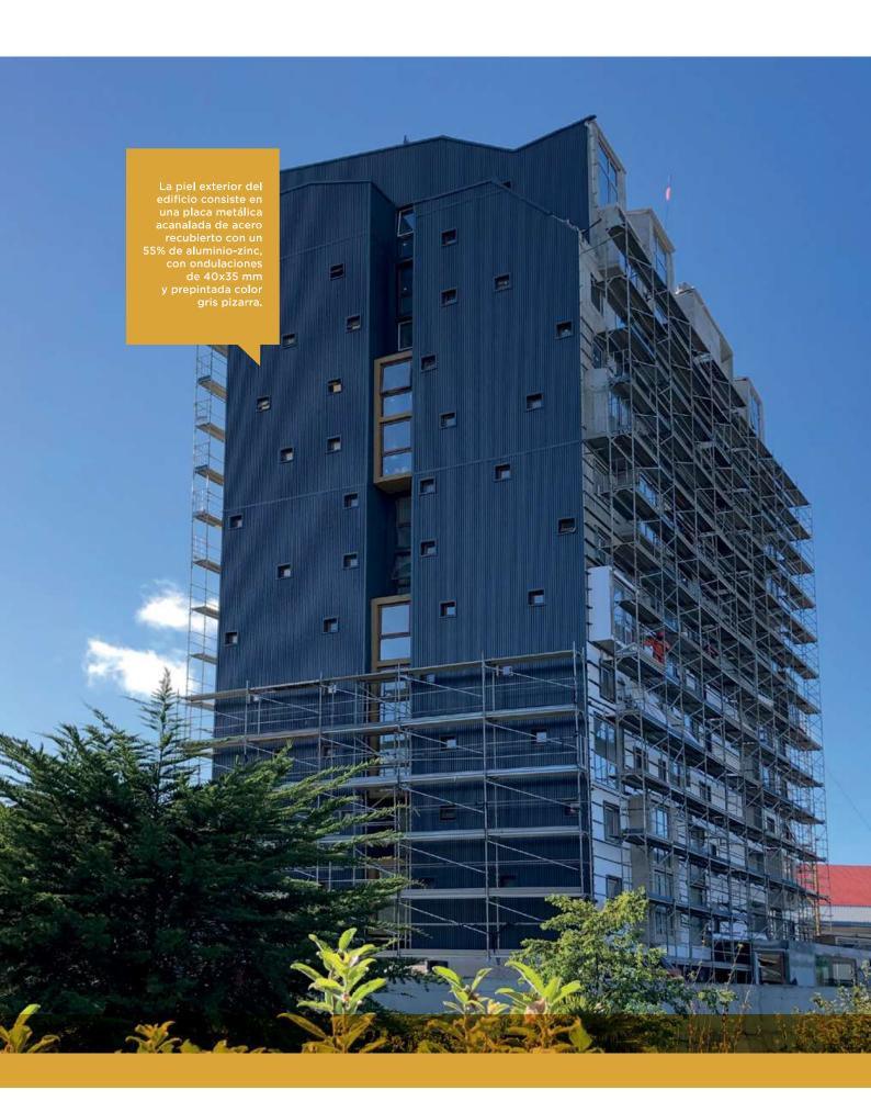
Para colocar el revestimiento se trabajó con andamios exteriores. La mayoría de las planchas metálicas se subieron a través de huinches por las cuatro fachadas. Para las terminaciones y remates se utilizaron alza hombres.
