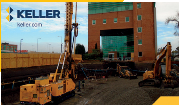
Columnas de Grava en Edificación (CHILE)
