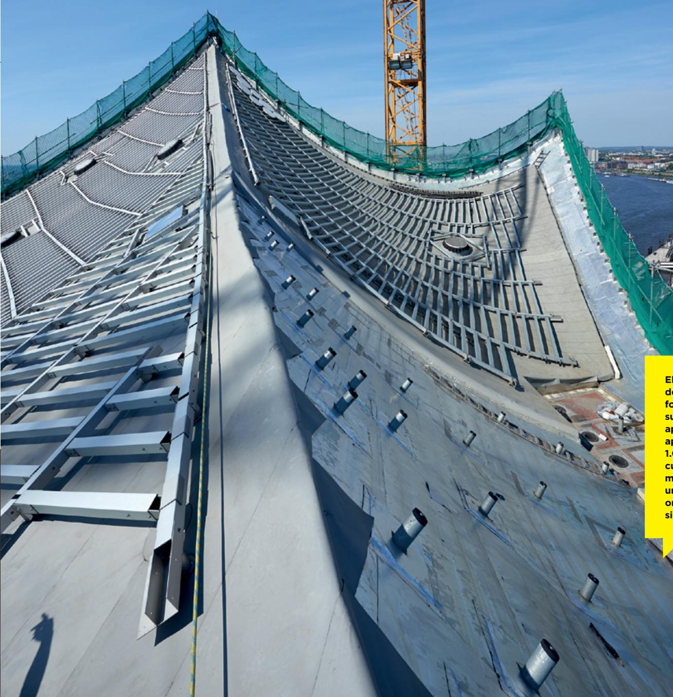
El área de techo es de 6.200 m<sup>2</sup> y está formada por ocho superficies cóncavas apoyadas en aproximadamente 1.000 vigas de acero curvadas individualmente. Éstos crean una geometría ondulada de la silueta de la azotea.
