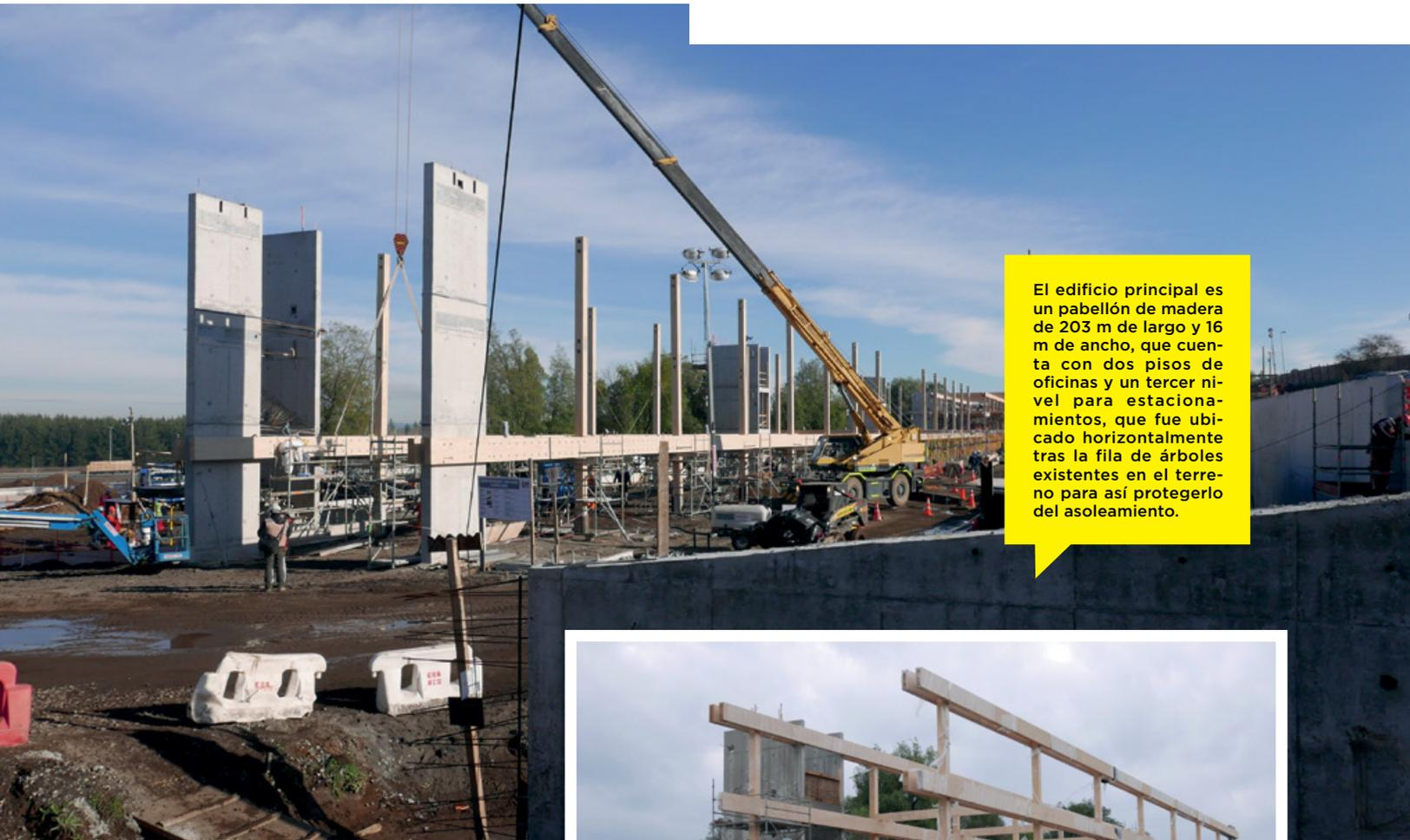
El edificio principal es un pabellón de madera de 203 m de largo y 16 m de ancho, que cuenta con dos pisos de oficinas y un tercer nivel para estacionamientos, que fue ubicado horizontalmente tras la fila de árboles existentes en el terreno para así protegerlo del asoleamiento.
