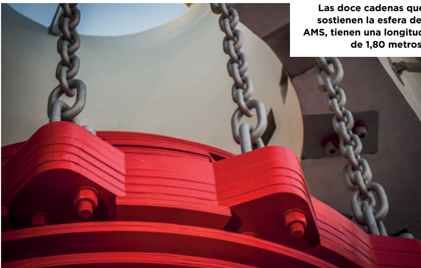
La esfera está conectada a dos amortiguadores viscosos de grandes dimensiones que limitan su rango de movimiento y que transmiten las ondas del péndulo a la estructura.
