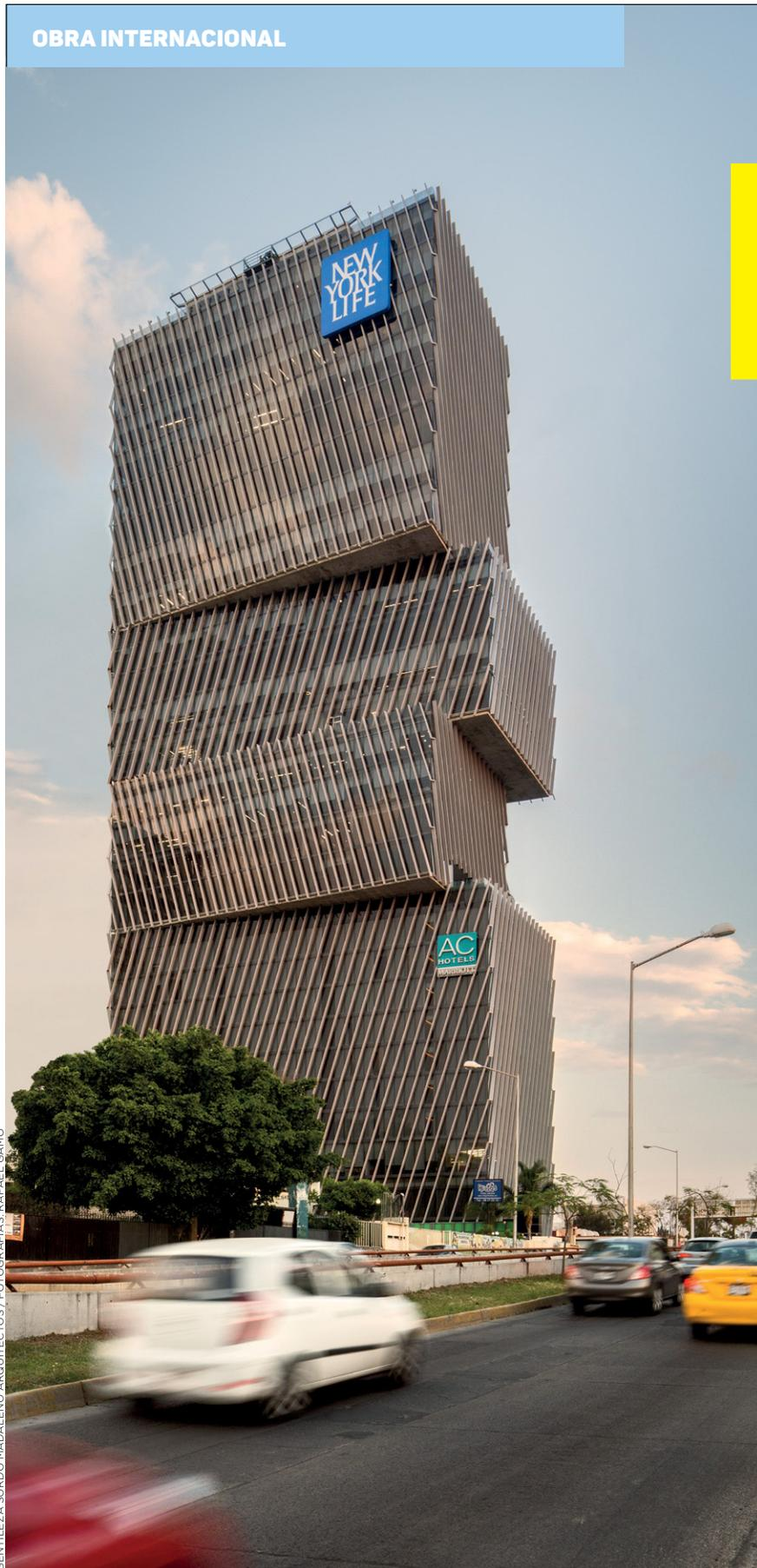
**En cuanto al diseño estructural, la obra es a base de concreto con losas postensadas y con un núcleo de circulación central.**
