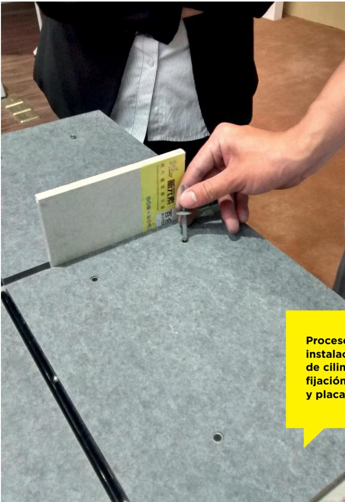
Proceso de instalación de cilindro de fijación, remache y placa.
