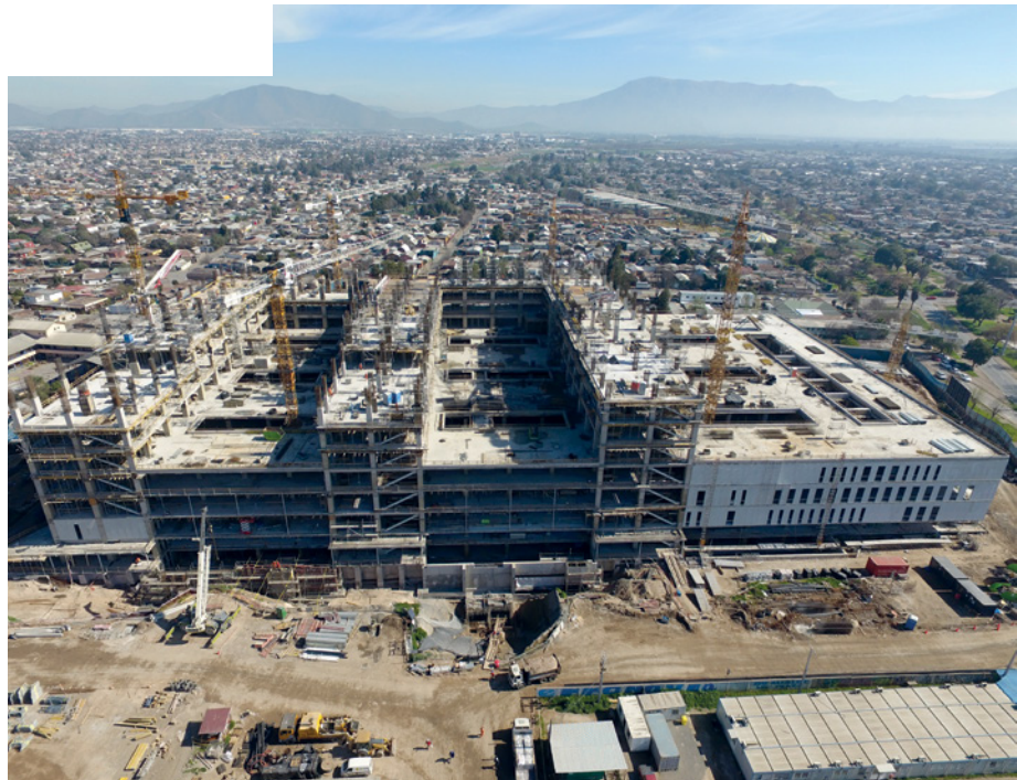
Para la obra gruesa se ejecutó el sistema tradicional de hormigón armado para fundaciones, muros, pilares y capiteles. Las losas y vigas se construyeron con el sistema de postensado.
