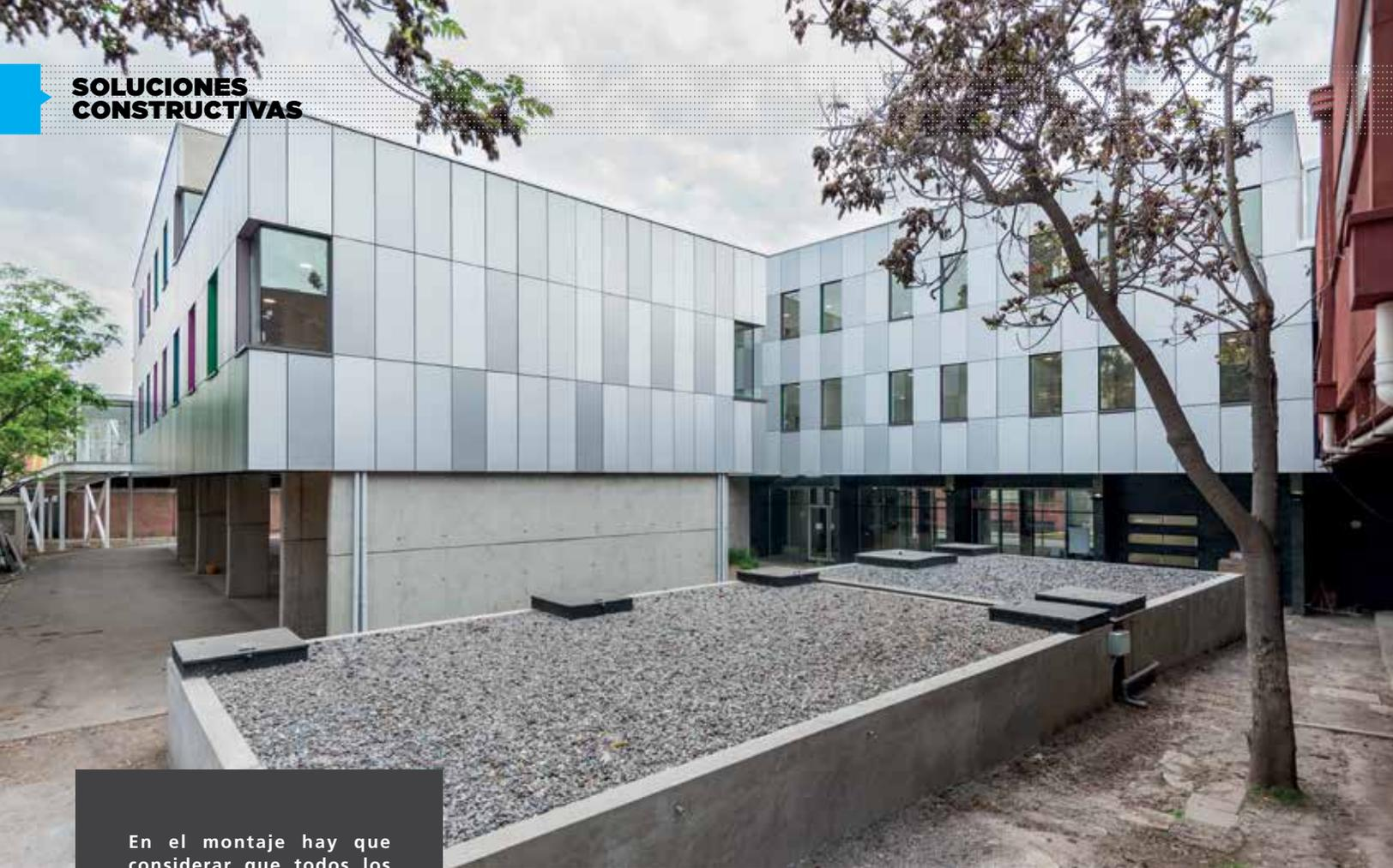
En el montaje hay que considerar que todos los componentes de aluminio sin recubrimiento en contacto directo con superficies de cemento, tales como muros de hormigón fresco, siempre deben estar separados con elementos protectores.
