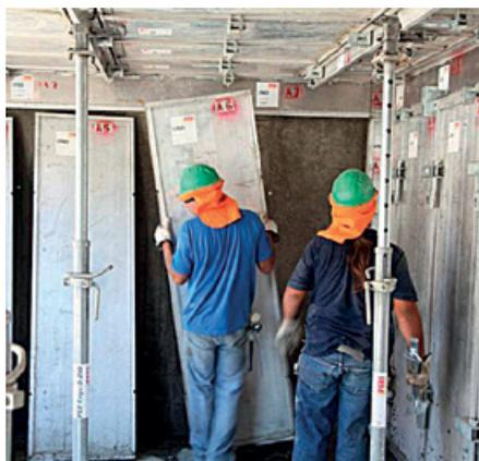
Al día siguiente del hormigonado, debe realizarse el proceso conocido como desencofre o descimbre, donde cada armador empieza retirando los accesorios de alineación y paneles simultáneamente.
