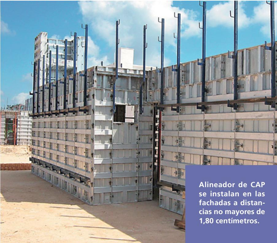
Alineador de CAP se instalan en las fachadas a distancias no mayores de 1,80 centímetros.
