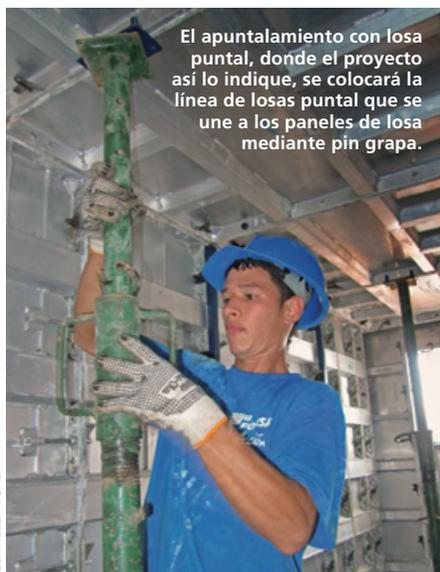
El apuntalamiento con losa puntal, donde el proyecto así lo indique, se colocará la línea de losas puntal que se une a los paneles de losa mediante pin grapa.
