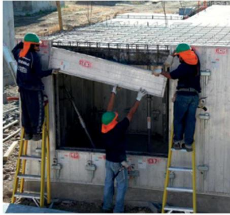
Terminados de fijar los paneles de muros interiores, se van montando y uniendo el resto de paneles de losa entre sí con el cerrojo correspondiente, hasta completar la losa de cada espacio o habitación.
