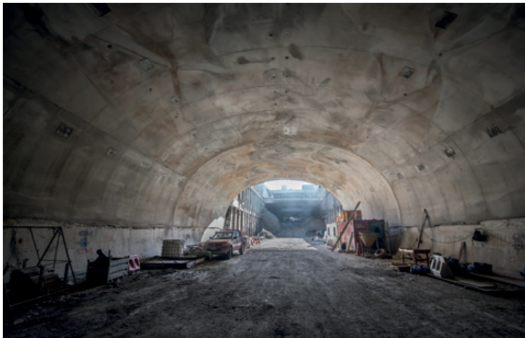
Revestimiento final salida túnel Kennedy, sector Américo Vespucio.
