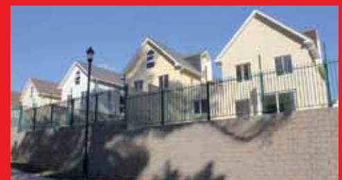
Muro Bloques - Montemar
