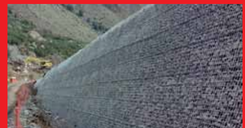
Muro Anti avalanchas - Alto Maipo
