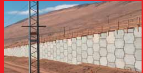
Muro Panel - Acceso Sur a Iquique
