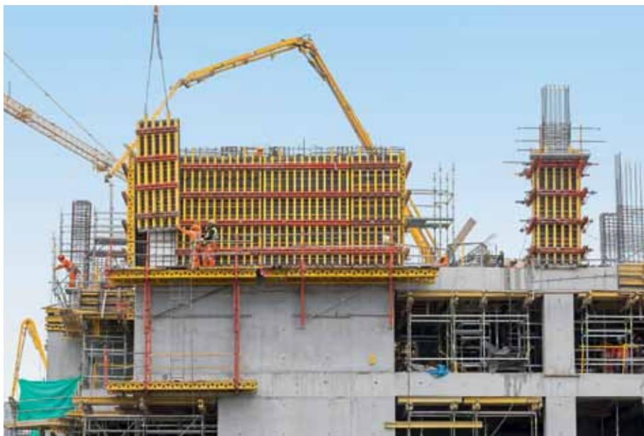
En la estructura se emplearon encofrados con planchas fenólicas de 1,5 x 3 metros para cumplir con los plazos de construcción.
