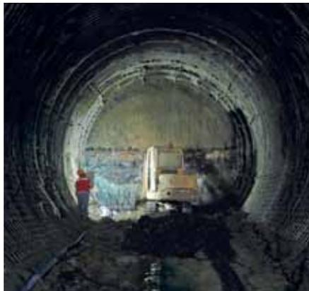
Los ductos avanzan hasta llegar a la casa de máquinas, estructura diseñada para alojar dos turbinas Francis de eje vertical de 10 MW de potencia cada una. “Las turbinas y los generadores están alojados en el fondo de un pique fortificado circular de 50 m de profundidad y 19 m de diámetro interior. En la parte superior está el patio de montaje, la sala eléctrica, los sensores y otras dependencias”, detalla Advis.
