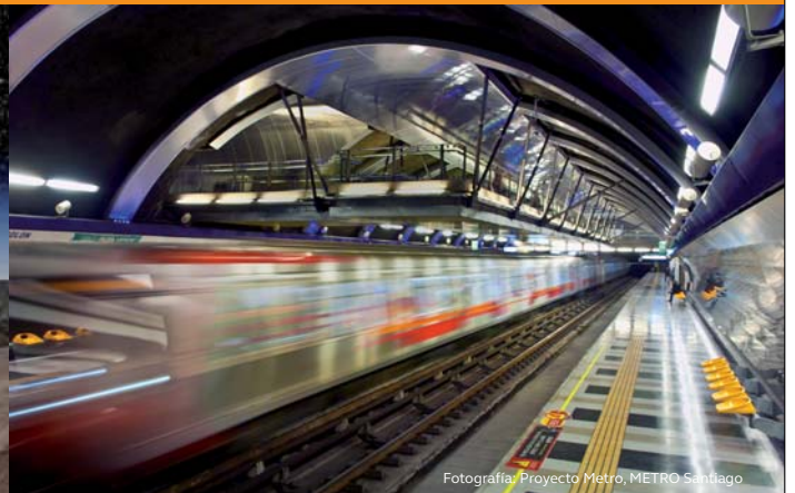
Fotografía: Proyecto Metro, METRO Santiago
