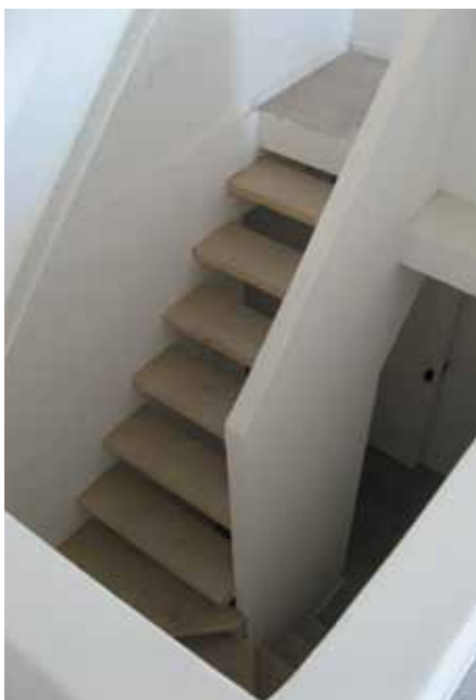
El proyecto destaca por su dúplex y triplex que permitió obtener una mayor cantidad de viviendas.
