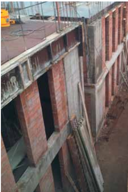
Con respecto a la materialidad de las viviendas se constituyen de albañilería reforzada y ladrillo.
