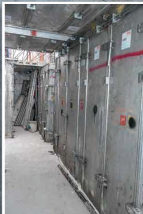
Un desafío del proyecto fue solucionar el escape de lechada que era perjudicial en el ciclo de hormigonado. Para esto se aplicó espuma de poliuretano en spray y una banda sello moldaje, lo que cumplió una doble función: retener la lechada y evitar la limpieza posterior.
