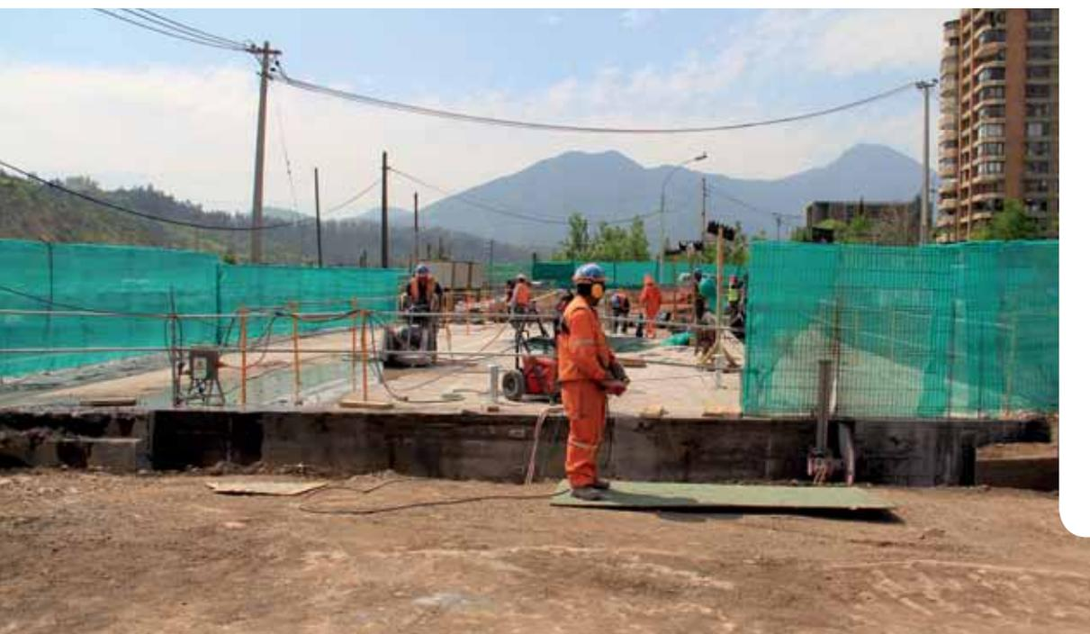
Al cierre de esta edición se estaba trabajando en la demolición del estribo y las alas de puente poniente. Una vez completado lo anterior se continuaría con la demolición del estribo sur y alas del puente oriente. A su vez, los avances dependen de las obras adicionales, entre ellas, la instalación de pilotes para el posicionamiento de otras estructuras.
