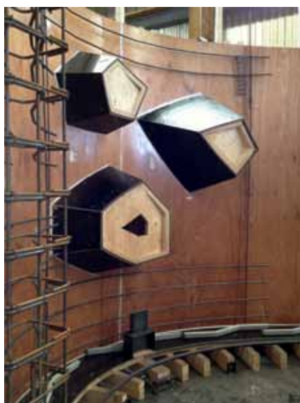
La geometría del polígono de las ventanas de aluminio se solucionó utilizando herramientas que simulan las tres dimensiones.
