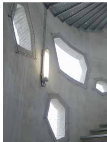
Las aberturas de la torre del ascensor y las escaleras fueron equipadas con una malla inoxidable simple.
