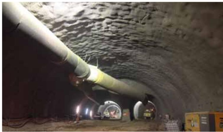
La excavación se realizó mediante medios mecánicos y el sostenimiento con proyección de hormigón, malla metálica y marcos reticulados. "Utilizamos la sección completa, colocamos el marco de manera total, ayudado de las plataformas, de las excavadoras y shotcreteamos. Ese sería el ciclo del frente de avance", ilustra Pablo de Luis.
