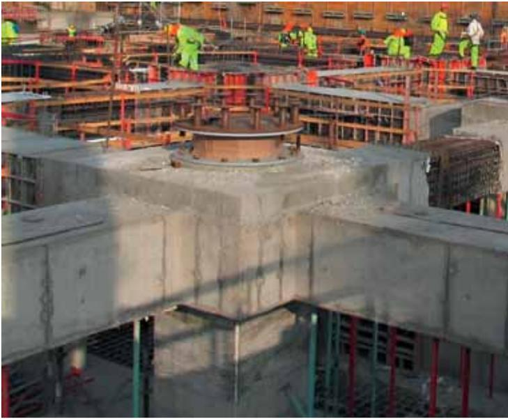
El establecimiento se encontrará apoyado sobre un sistema soportante basal de 193 aisladores sísmicos, de plomo y de alto amortiguamiento con y sin núcleo central, según requerimientos de diseño.
