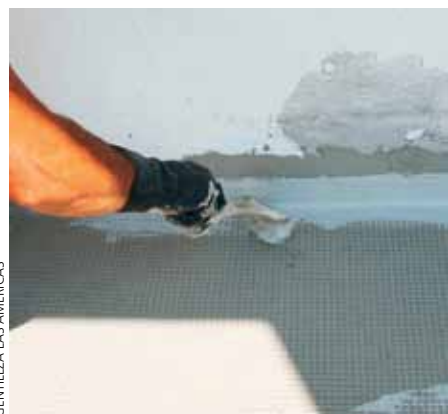
Para superficies horizontales se recomiendan impermeabilizantes minerales para losas (NanoFlex® ECO) y productos en base a cal, los que se amasan con agua y se aplican con llana o rodillo, formando una capa mineral de 2 a 3 mm que se integra al sustrato, que no permite el paso del agua o humedad, pero que sí deja salir la humedad contenida en el interior.
