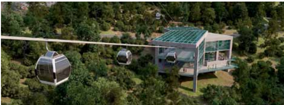
Las góndolas que trasladarán a 3.000 personas, tendrán una velocidad máxima de desplazamiento de 22 kilómetros por hora en el trayecto colgante y de 7 km/h en cada estación.
