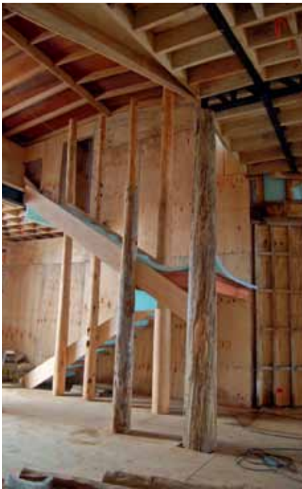
En recintos de mayor dimensión, se combinó la madera con estructuras metálicas para lograr mayores luces sin apoyos y resistir los fuertes vientos.
