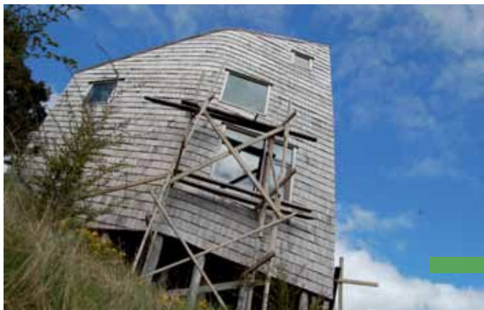
Para lograr hacer techos de tejuela sin filtraciones, se sellaron todos los techos con membrana asfáltica, sobre la cual se tramó la estructura de madera atornillada en pocos puntos para no romper la membrana.
