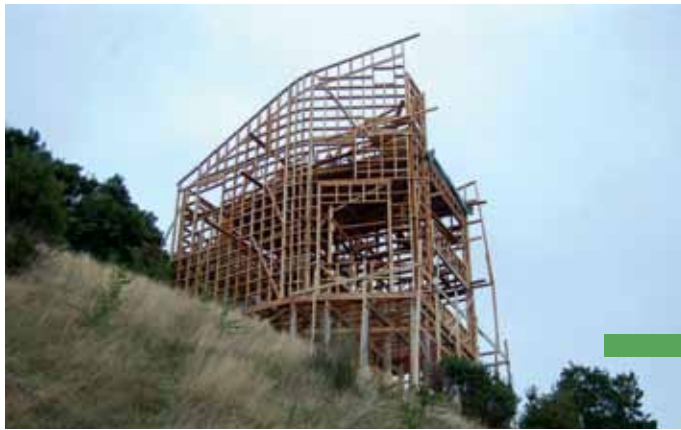
Uno de los principales desafíos fue lograr que el total de las construcciones se hiciera con maderas nativas y de bajo impacto en el terreno. La superficie, además, posee fuertes pendientes.
