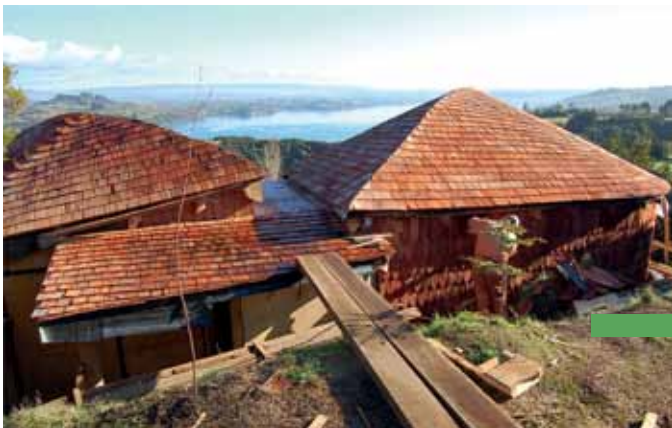
Para lograr hacer techos de tejuela sin filtraciones, se sellaron todos los techos con membrana asfáltica, sobre la cual se tramó la estructura de madera atornillada en pocos puntos para no romper la membrana.
