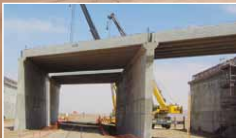
• Vigas Prefabricadas Rutas Antofagasta
