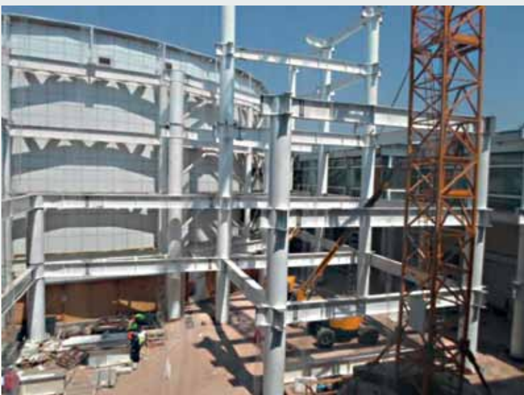
En el sector de control emigraciones, se construyó un edificio adosado al existente fundado sobre pilotes y micropilotes, en base a una estructura de acero, losas colaborante y muro cortina perimetrales.
