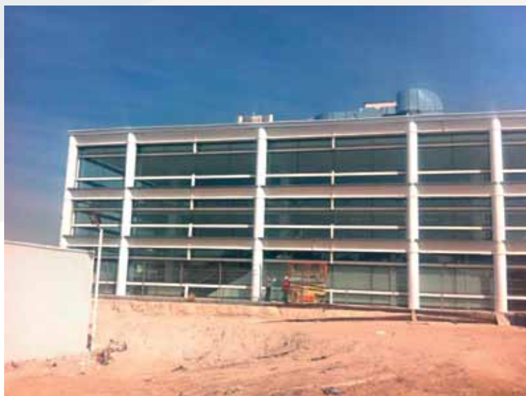
Para el incremento del embarque remoto internacional, se construyó un edificio de tres niveles adosado al existente, fundado sobre pilotes en base a una estructura de acero con losas colaborantes y muro cortina perimetrales.
