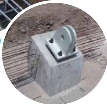
Para poder instalar los pilares, se realizaron fundaciones de 3 x 3 metros, dejando los pernos de anclaje en el lugar, de manera tal de recibir las estructuras.
