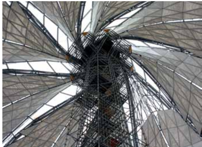
Vista interior hacia el anillo superior donde convergen las alas, oculto por la torre temporal y donde se aprecia el avance del revestimiento de mármol ya instalado. Las alas del templo, hechas de acero estructural, tienen una altura de 30 metros.
