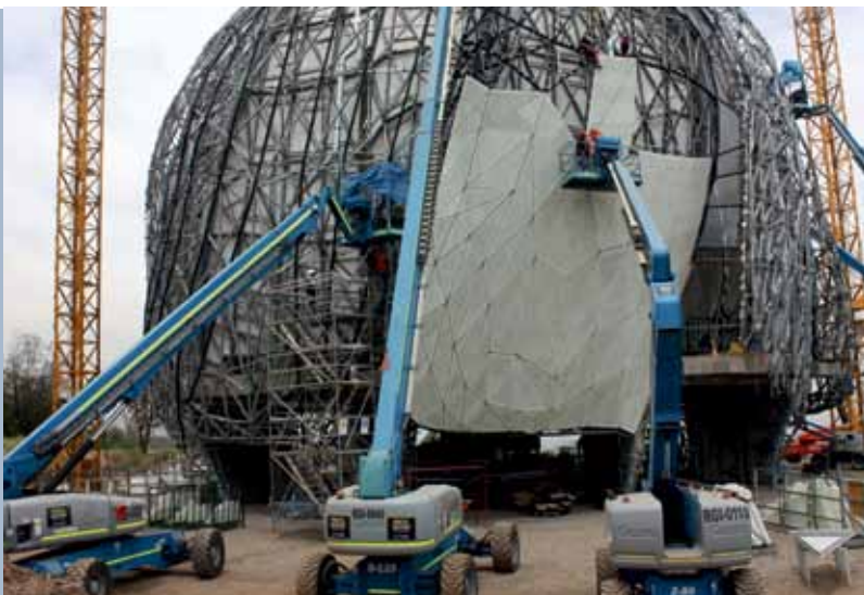
Para la instalación de las ventanas corridas, se utilizó un sistema con ventosas. De esta forma se podía izar el elemento con ayuda de una grúa para ser acomodado por los trabajadores.
