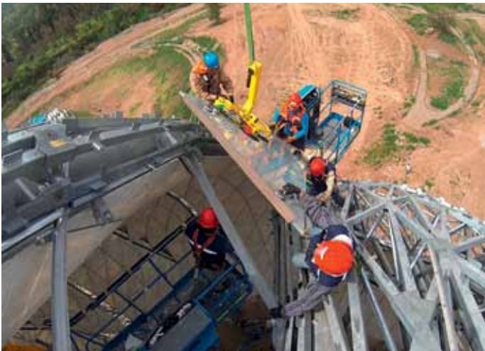
Para la instalación de las ventanas corridas, se utilizó un sistema con ventosas. De esta forma se podía izar el elemento con ayuda de una grúa para ser acomodado por los trabajadores.
