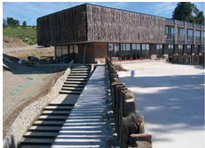
cia del edificio según la época del año gracias a las características de la madera, grafica el arquitecto. En tanto, las escaleras no son durmientes sino madera reciclada, dimensionada en obra y fijada con un pegamento de adherencia para exteriores.
