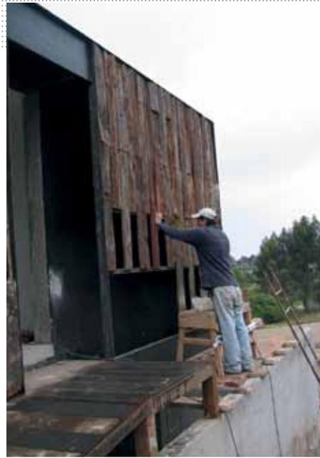
La envolvente es una piel ejecutada con bastidores de acero, en los cuales se incluyó madera en forma de troncos longitudinales. En la piel inferior se utilizó madera reciclada de raíces encontradas en la cercanía del lugar. A estas no se les aplicó ningún tratamiento con la finalidad de que tengan una respuesta natural al ambiente.
