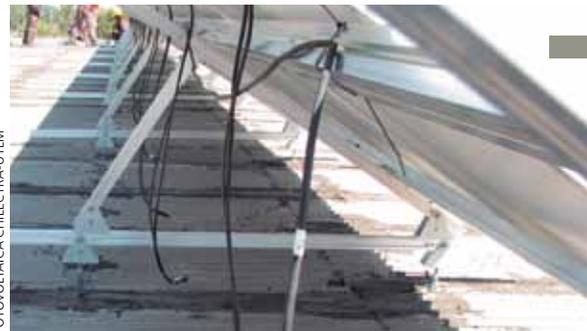
La distancia entre la superficie de montaje y los módulos debe permitir que circule el aire en la parte trasera del módulo, asegurando la suficiente ventilación de los estos.
