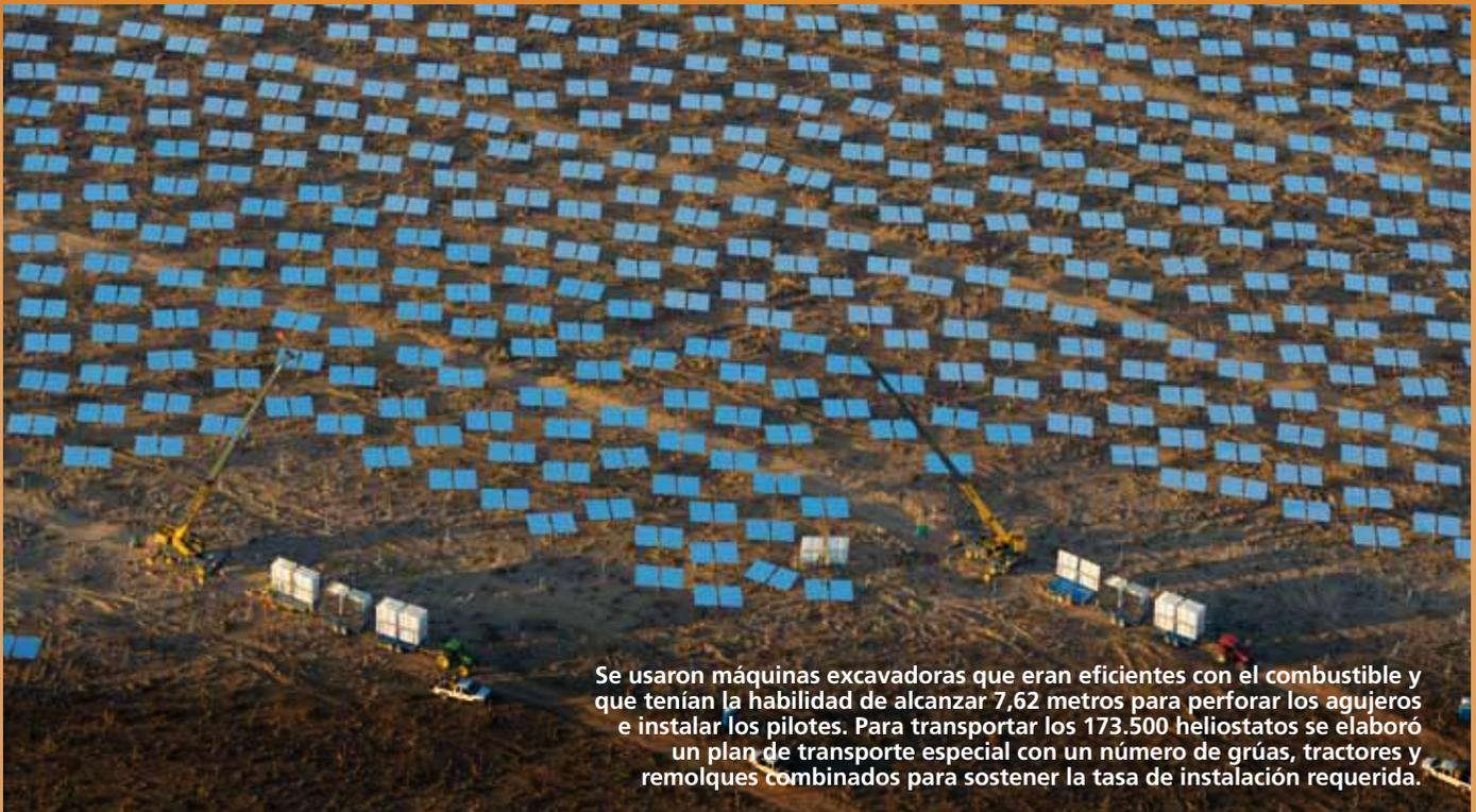
Se usaron máquinas excavadoras que eran eficientes con el combustible y que tenían la habilidad de alcanzar 7,62 metros para perforar los agujeros e instalar los pilotes. Para transportar los 173.500 heliostatos se elaboró un plan de transporte especial con un número de grúas, tractores y remolques combinados para sostener la tasa de instalación requerida.
