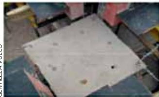
El grout debe quedar completamente nivelado, vale decir en un mismo plano con respecto al extremo de los Manguitos. (Ver Esquema )
