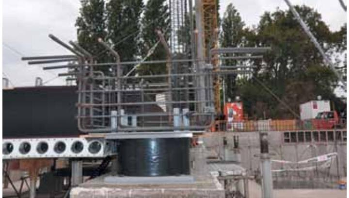
dos que se debe considerar en el montaje de los aisladores sísmicos, es la instalación y fijación del sistema de insertos al hormigón, compuestos por barras de anclaje y manguitos con hilo interior. Estos elementos deben ser correctamente nivelados en forma previa al montaje de los aisladores. En general cada fabricante tiene su procedimiento, no obstante, la mayoría utiliza plantillas para el posicionamiento en planta de los insertos a hormigón.
