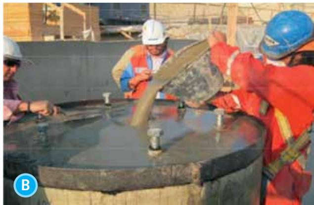
**B.** Una vez fraguado el hormigón, se deberá proceder a saturar de agua la superficie (previo a la colocación del grout) para evitar que el hormigón absorba agua del grout. Finalmente tomar las precauciones necesarias para evitar que queden bolsones de aire; como también aislar de vibraciones cercanas el punto de colocación del relleno.
