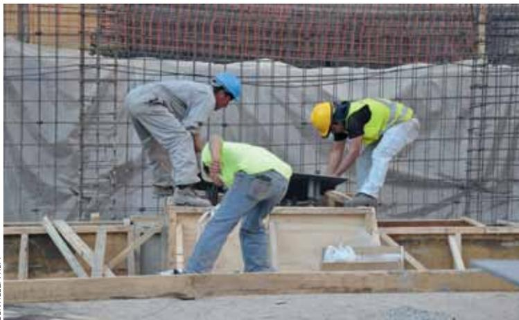
Primero hay que encajar y posicionar los insertos a hormigón utilizando las plantillas provistas por el fabricante de los aisladores.
