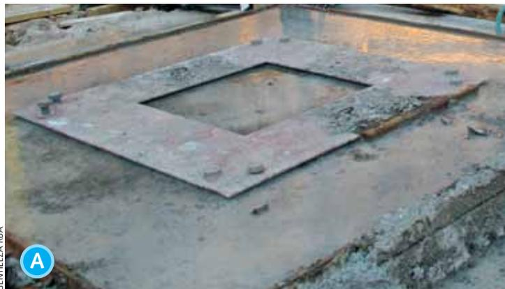
**A.** Posteriormente, se procede a hormigonar. Los manguitos deben sobresalir del hormigón típicamente entre unos 20 y 50 mm.
