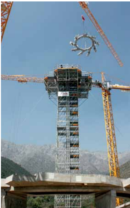
Desde el anillo salen las nueve "ramas" donde se conectan las estructuras primarias de cada pétalo.
