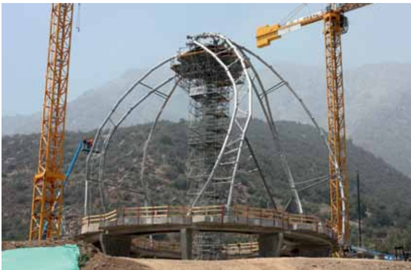
Desde el anillo salen las nueve "ramas" donde se conectan las estructuras primarias de cada pétalo.
