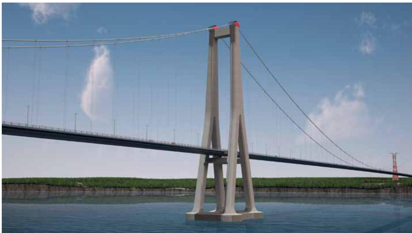
La fundación de la pila Central sería de 9.550 m<sup>3</sup> de hormigón y de 1.700 toneladas de acero. Para la del Sur sería de 3.600 m<sup>3</sup> de hormigón y de 300 toneladas de acero y la del Norte contaría de 5.300 m<sup>3</sup> de hormigón y 850 toneladas de acero.
