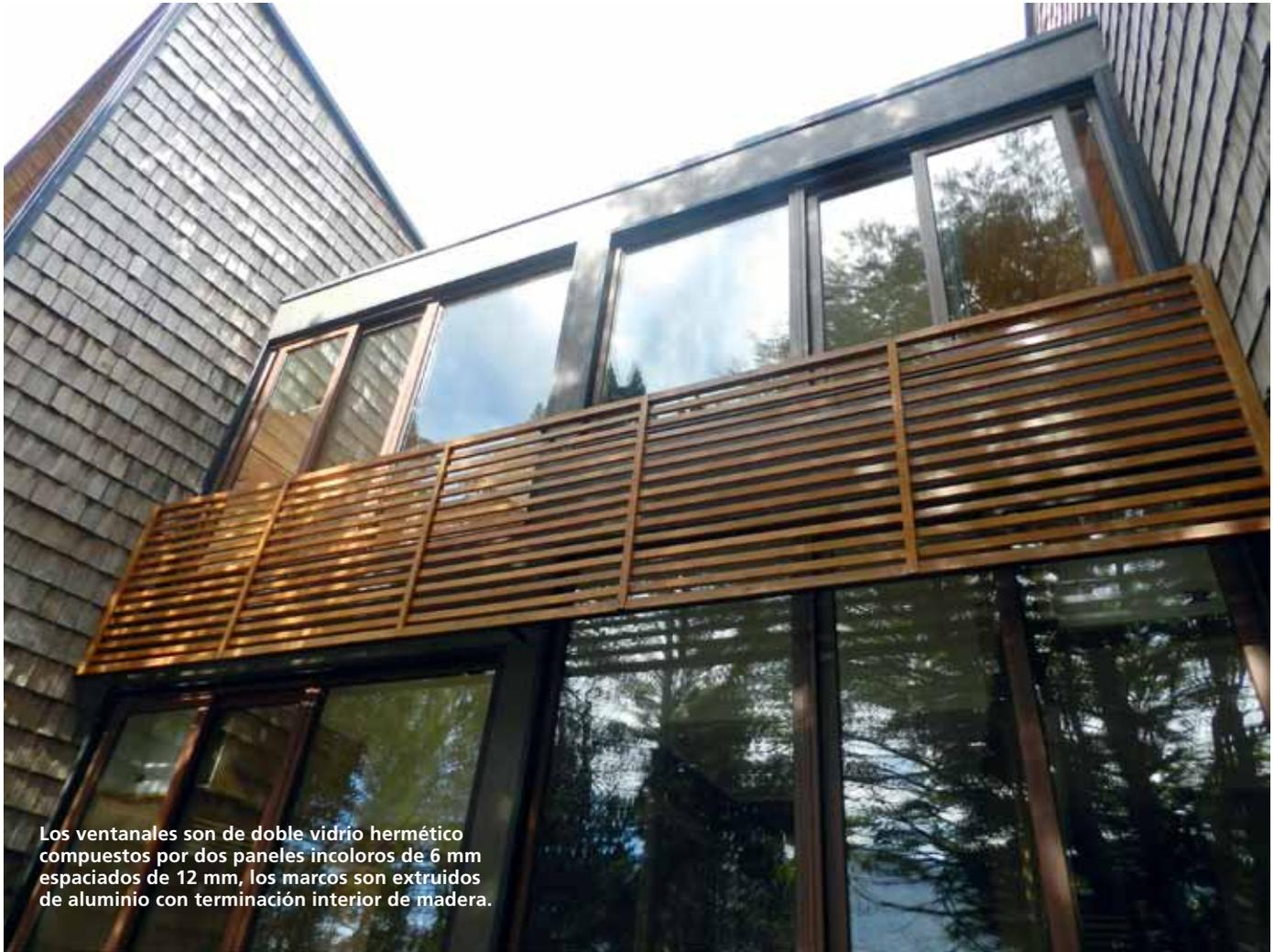
Los ventanales son de doble vidrio hermético compuesto por dos paneles incoloros de 6 mm espaciados de 12 mm, los marcos son extruidos de aluminio con terminación interior de madera.
