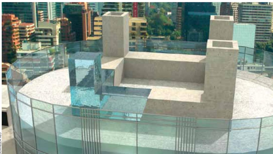
**FIGURA 1.** Representación artística del disipador de columna líquida bidireccional instalado en el nivel superior de un edificio. Se muestra en la figura el agua que se ubica en una de las columnas y ductos adyacentes del dispositivo.
