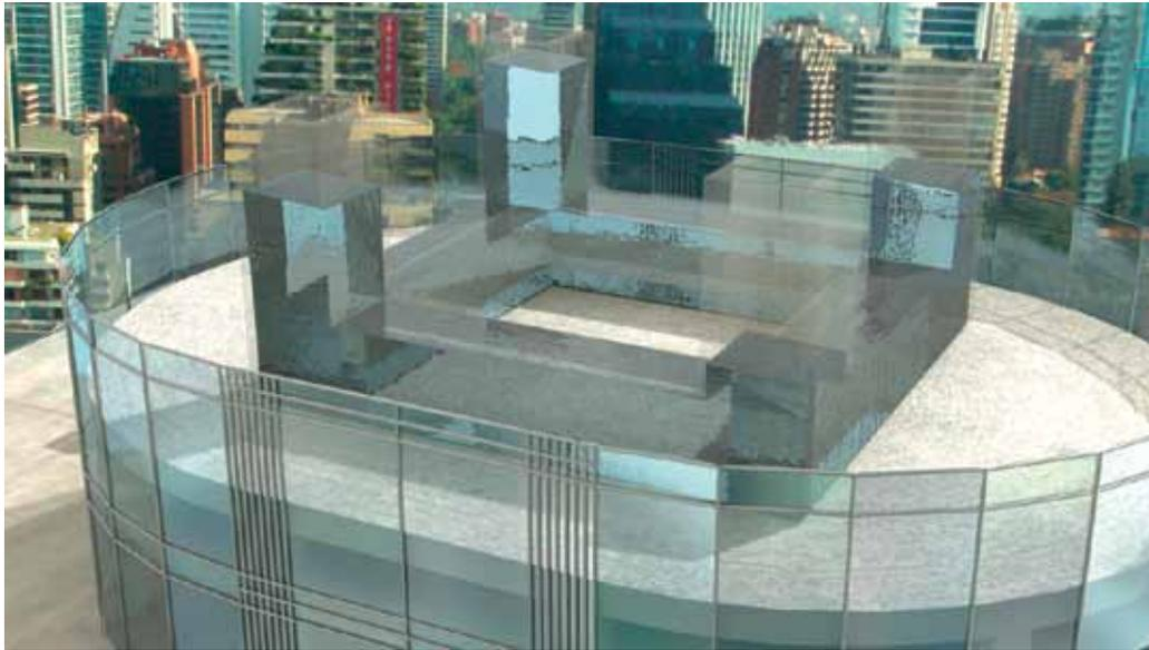
**FIGURA 2.** Vista del disipador sujeto a la acción de una aceleración en su base (las columnas del disipador se omiten por claridad). Si el edificio se mueve hacia la derecha, las fuerzas inerciales de la masa de líquido en el interior del disipador empujan a la estructura en el sentido contrario reduciendo de esta forma su deformación.
