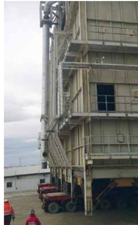
Para mover los módulos se utilizaron vehículos a control remoto que se posicionaban debajo de estos y los levantaban hasta que los pies de apoyo quedaran en el aire.
