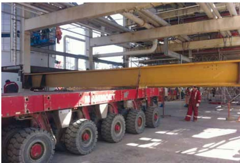
**El proceso de ubicación y ajuste bajo cada módulo o equipo de las plantas se realizó situando el carro bajo la unidad a remover que previamente habían sido modificados con refuerzos estructurales que les permitían el izamiento y transporte.**
