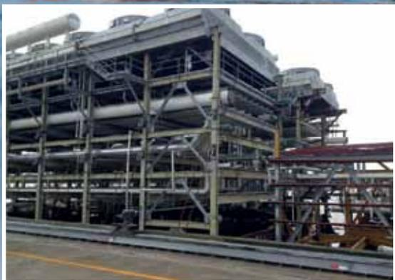
Los módulos medían en promedio unos 40 metros de ancho por 20 m de alto y tanto para el desarme de la planta como para el armado de estos, se utilizaron grúas de ayuda de capacidades de 800 toneladas de peso.
