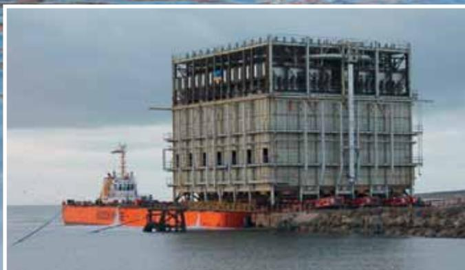
Los módulos se apenan a soportes soldados a los pallets del barco y sus puntos altos se afianzan por medio de cables a la base de las barcasas.
