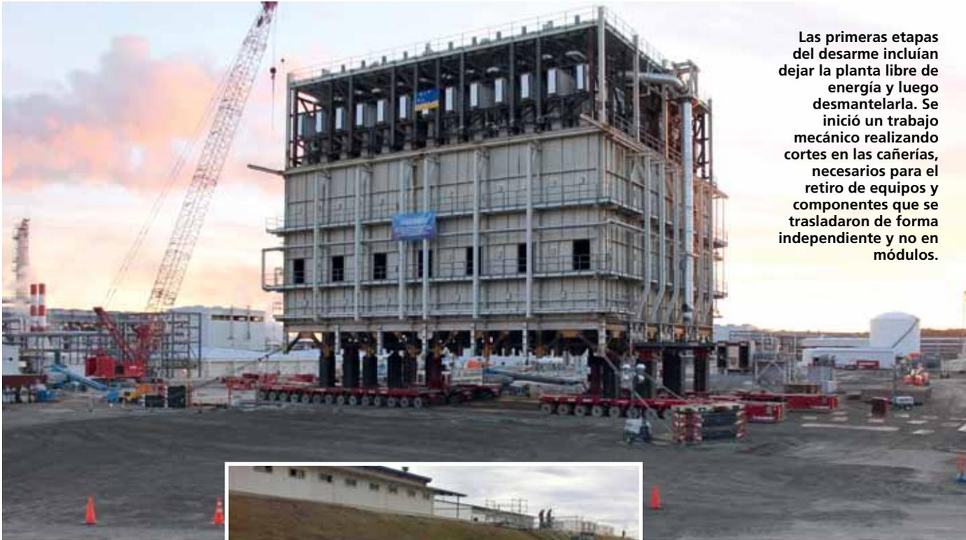
Las primeras etapas del desarme incluían dejar la planta libre de energía y luego desmantelarla. Se inició un trabajo mecánico realizando cortes en las cañerías, necesarios para el retiro de equipos y componentes que se trasladaron de forma independiente y no en módulos.
