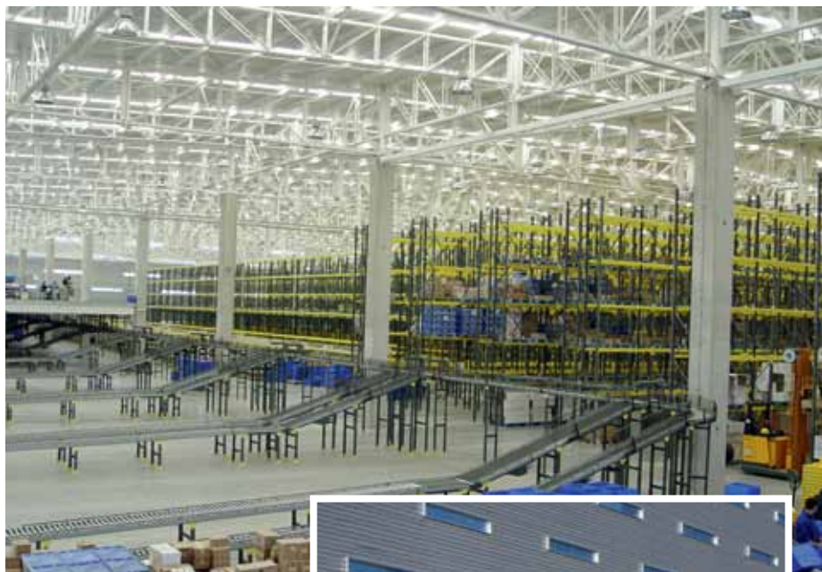
El Centro de Distribución y Logística de Farmacias Ahumadas S.A. incorpora la energía geotérmica para enfriar o calentar el aire interior. El aire que es inyectado al interior del edificio posee una temperatura promedio entre los 18° C y 24° C, tanto en invierno como en verano.
