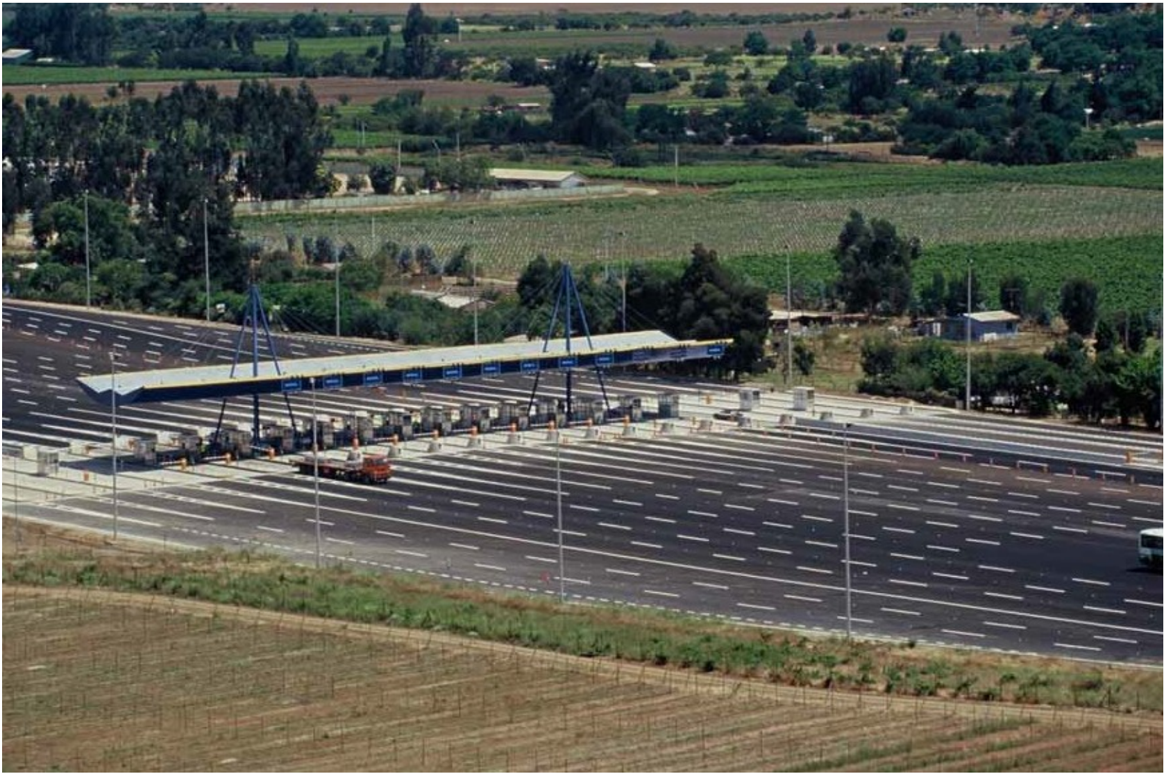
En la Ruta 68 (Rutas del Pacífico) hay un importante plan de mejoras a largo plazo, que tendrá un costo de US$365 millones. Entre sus principales mejoras se encuentra a ampliación de capacidad desde Américo Vespucio hasta el Peaje Lo Prado.
