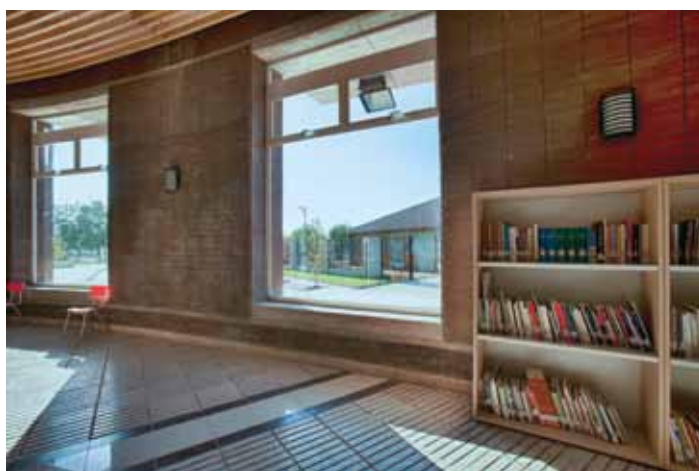
Para el enchapaje de los muros curvos, se debió escoger en algunos casos los enchapes de manera unitaria y contar con una mano de obra especializada, cuidando de mantener la curvatura.
