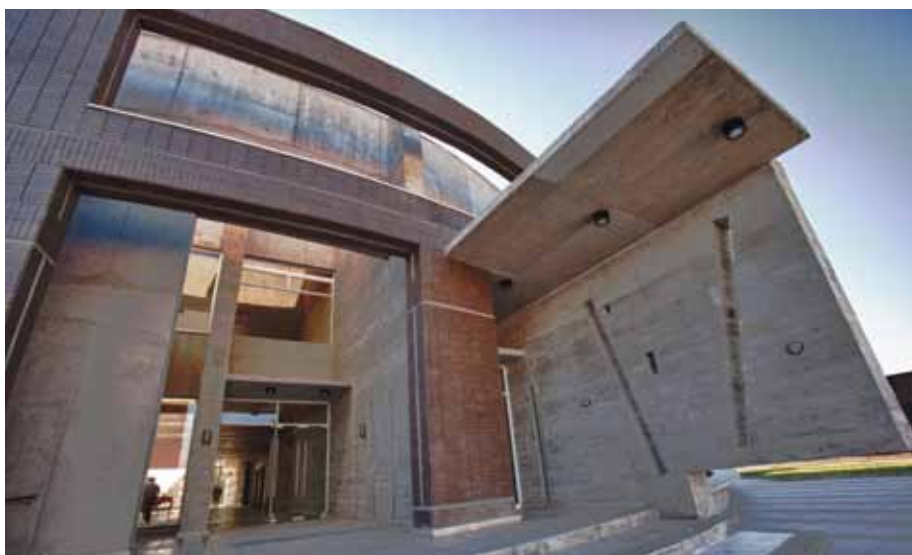
Para el enchapaje de los muros curvos, se debió escoger en algunos casos los enchapes de manera unitaria y contar con una mano de obra especializada, cuidando de mantener la curvatura.
