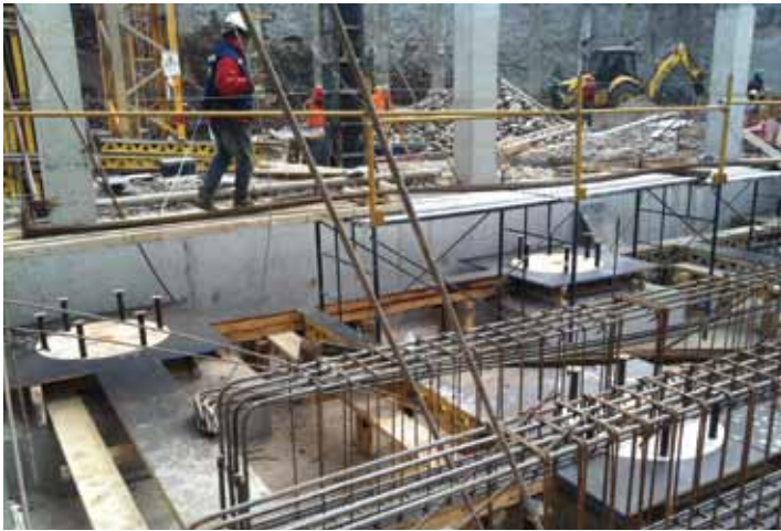
Para mantener la continuidad operativa en caso de movimientos telúricos, se aplicaron 43 aisladores sísmicos elásticos y 13 deslizadores friccionales.
