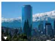
Sistema de disipación de energía, Torre Titanium.
