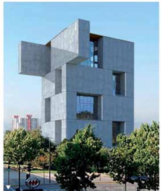
Diseño estructural y sistema de aislamiento sísmico, Centro de Innovación Tecnológica Anacleto Angelini.
