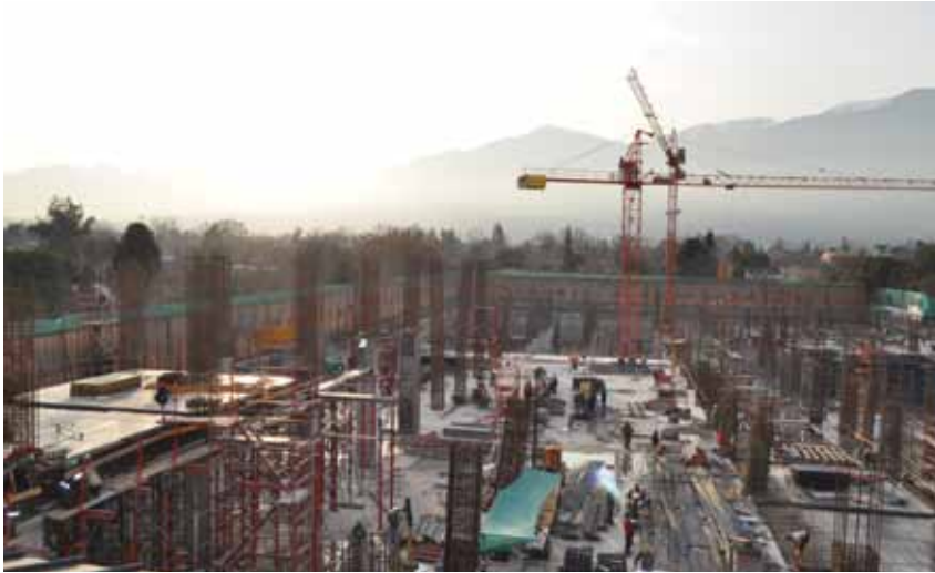
Estado de avance de las obras para el mes de julio de 2012. Se observa la ejecución de la obra gruesa. La inauguración se proyecta para el primer trimestre de 2013.
