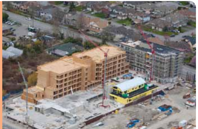
Edificio de seis pisos en proceso de construcción.
