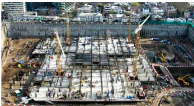
Construcción proyecto Costanera Center
