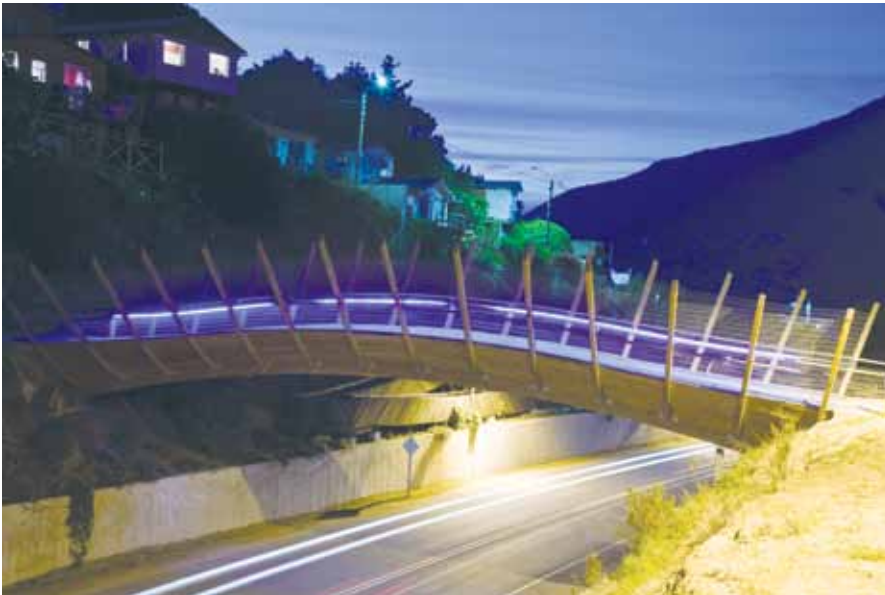
Vista nocturna de la obra terminada. Finalmente se incluyeron canaletas para la iluminación LED.
