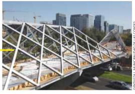
En términos prácticos, la pasarela se construyó en dos partes, unidas por una sección que funciona como un ajuste, una pieza de dilatación de aproximadamente 100 m². Justamente en esta parte, que coincide con el bandejón central de Av. Manquehue, es donde se abre el reticulado y se emplaza el mirador. Para efectos del diseño se pensó como un todo.
