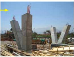
Para evitar la interferencia de obras civiles en Avenida Manquehue, se resolvió que el puente descanse en dos apoyos en forma de "V". Con una base de 1,80 m x 1,50 m, cada apoyo se sustenta en una zapata de 6,50 m x 6,50 m x 2m fundada aproximadamente a 3,50 m de profundidad.
