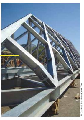
La estructura es completamente de acero, fabricada en maestranza y galvanizada, transportada por partes y montada en terreno. "Se trajo pieza a pieza, se prearmó a nivel de piso se montó cada tramo prearmado con una grúa sobre los pilares. Los pilares estaban con sus insertos, elementos de anclaje puestos. Se colocó y se remataron las conexiones.", explican los arquitectos.
