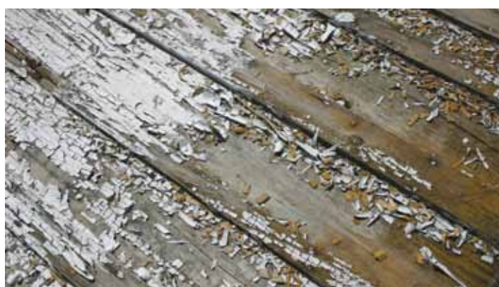
Las pinturas tradicionales para madera retienen la humedad, facilitando que se desprenda y desconche. Se debe pulir la superficie para su recuperación.
