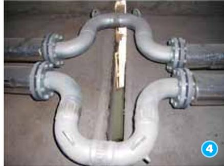
**1-2.** Para el soporte de cañerías y ductos de aire acondicionado, agua potable, electricidad y alcantarillado, se ejecutó un diseño de arriostros longitudinales y transversales. El diseño de cañerías se realizó con un estándar internacional para una zona sísmica similar o más severa que la correspondiente a la ubicación del hospital.
