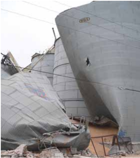
El terremoto de 2010 presentó exigencias de desplazamiento horizontal y vertical excesivamente grandes, según los expertos. Eso generó problemas en estructuras, incluso en acero.
